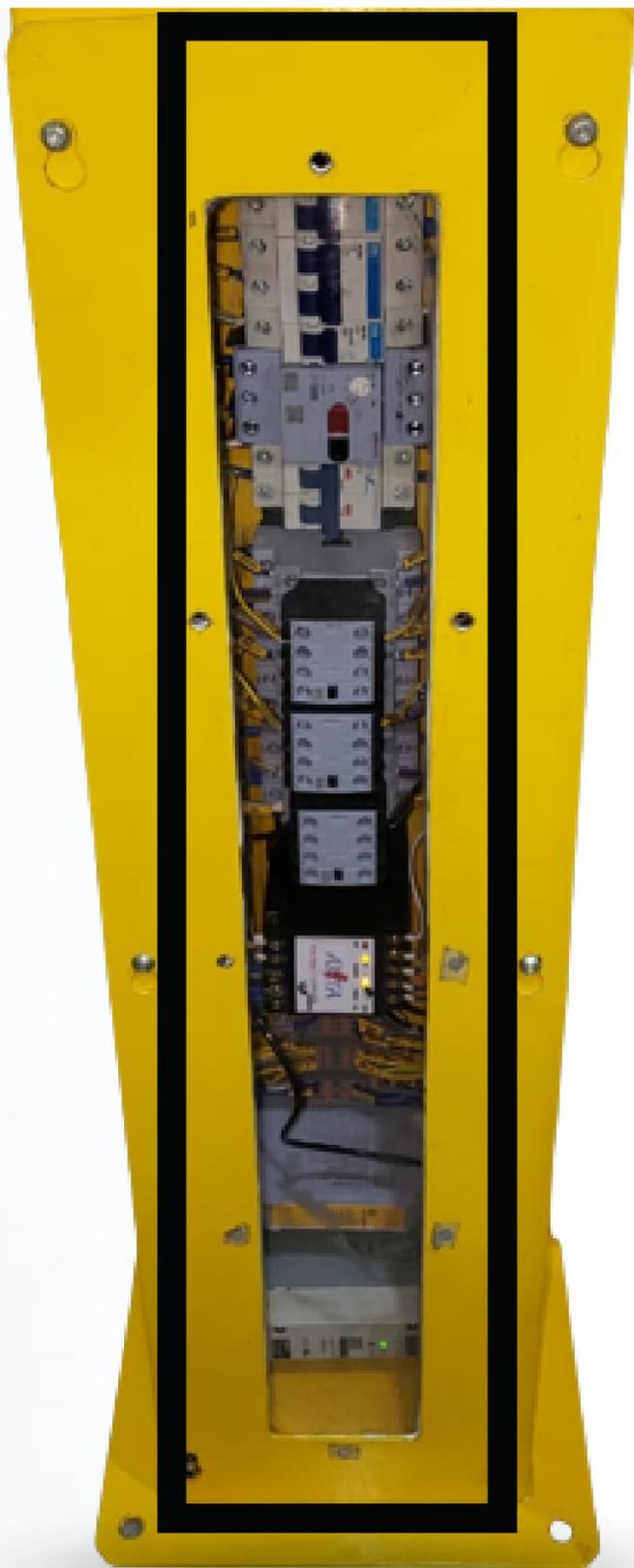
»»» PAINEL ELÉTRICO EMBUTIDO NA COLUNA
